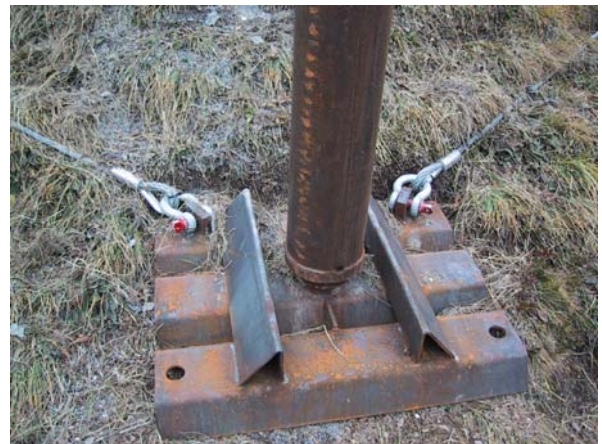
Установленное основание с опорой на шарнирах и верхними фиксирующими канатами.
