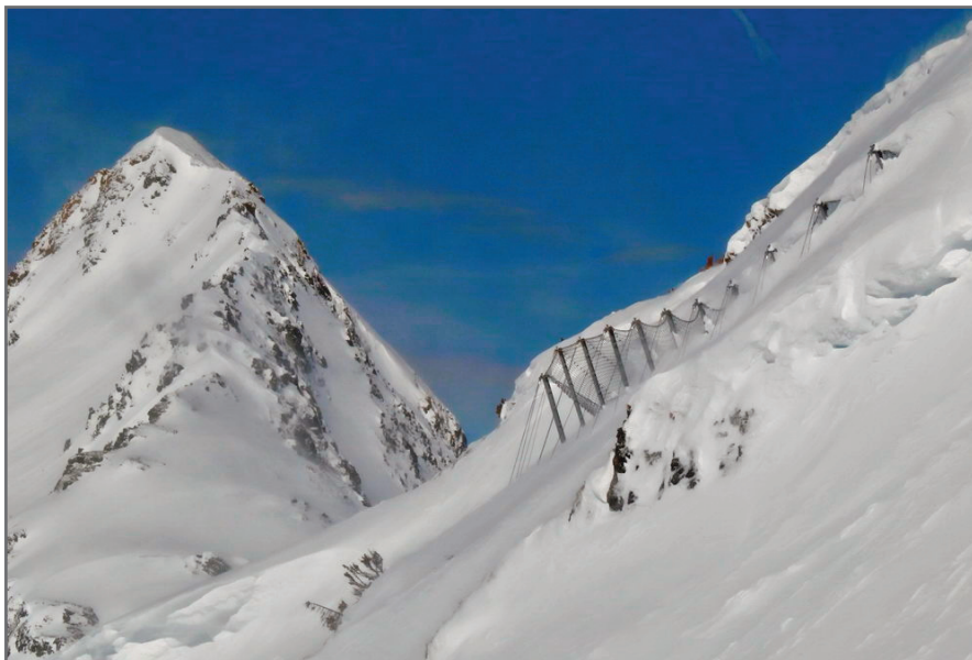
Рис. 7. Противолавинный барьер в зоне зарождения лавин
