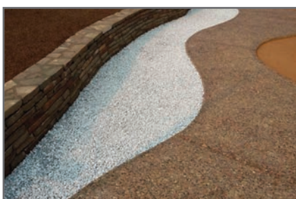
Рис. 6. Дорожка, вымощенная дренажным бетоном [5]
