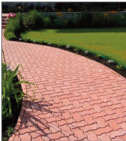
Рис. 9. Дорожка, вымощенная тротуарной плиткой, уложенной на песок (вода проникает через стыки между плитками) [2]
