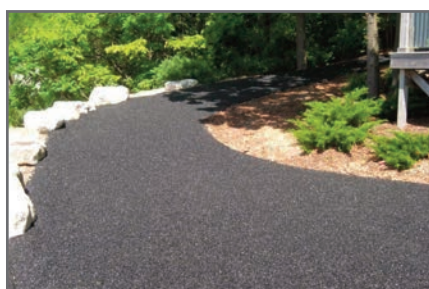
Рис. 7. Дорожка, вымощенная водопроницаемым покрытием Porous Pave из переработанной старой резины, гранитного заполнителя и жидкого связующего [7]
