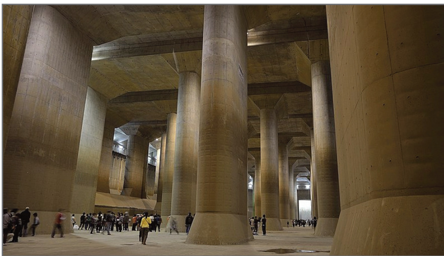
Рис. 12. Крупнейший в мире подземный противопаводковый коллектор в японском городе Касукабе, представляющий собой гигантскую разветвленную систему тоннелей и резервуаров размером с восьмизатяжные дома для сбора воды во время разливов рек из-за сильных ливней и тайфунов с ее при последующей перекачкой в реку Эдо [20]
