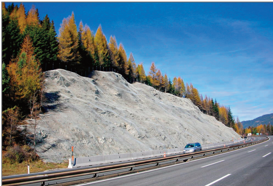
Рис. 5. Стабилизация склона с помощью закрепленного грунтовыми анкерами сеточного покрытия
