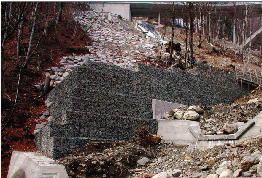
Рис. 6. Поддержка склона габионными конструкциями
