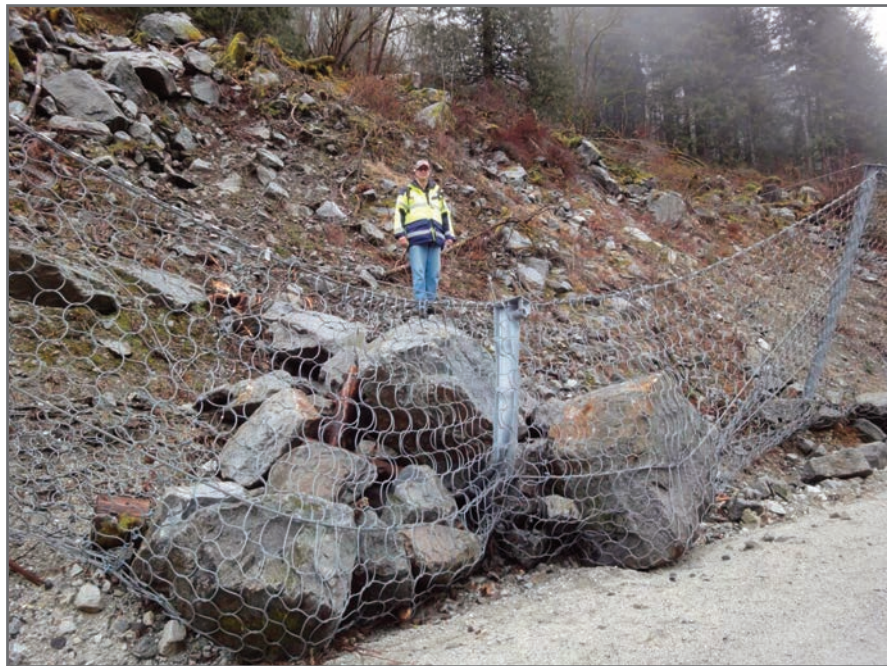
Рис. 1. Пример сработавшего противокамнепадного барьера компании Trumer Schutzbauten
