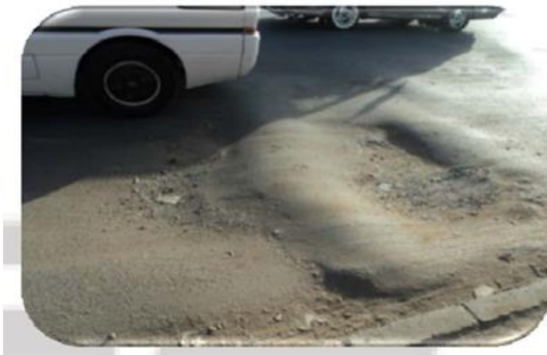
Рис. 4. Углубления и вспучивания на улице Аларда в г. Омдурмане [10]
