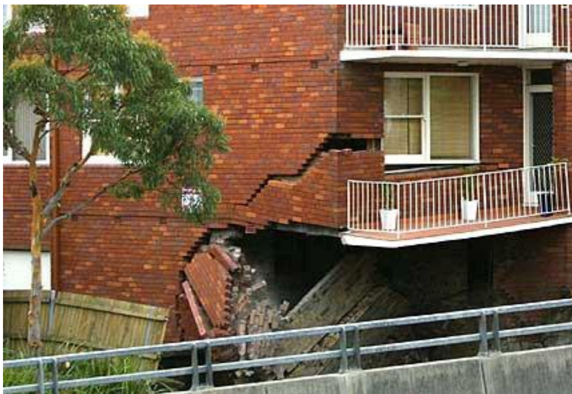
Рис. 2. Юго-западный угол жилого дома, поврежденный в результате обрушения автодорожного тоннеля Лейн-Коув в ноябре 2005 года ( https://www.tunneltalk.com/Lane-Cove-collapse.php )
