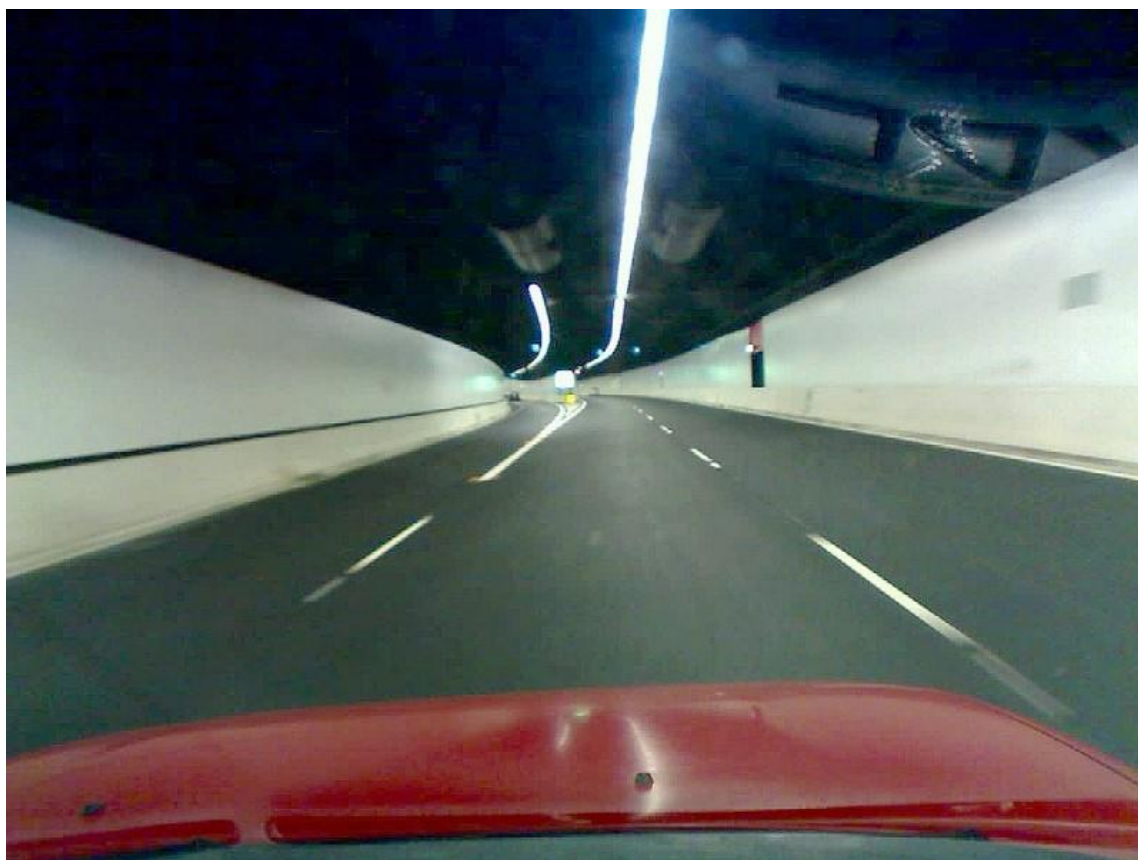
Рис. 3. В построенном автодорожном тоннеле Лейн-Коув (Сидней) ( https://en.wikipedia.org/wiki/Lane_Cove_Tunnel )
