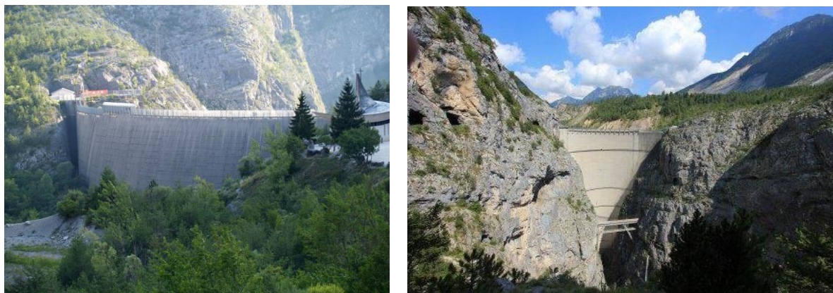
Рис. 7. Плотина Вайонт со стороны верхнего (а) и нижнего (б) бьефов в наши дни [16, 17]
