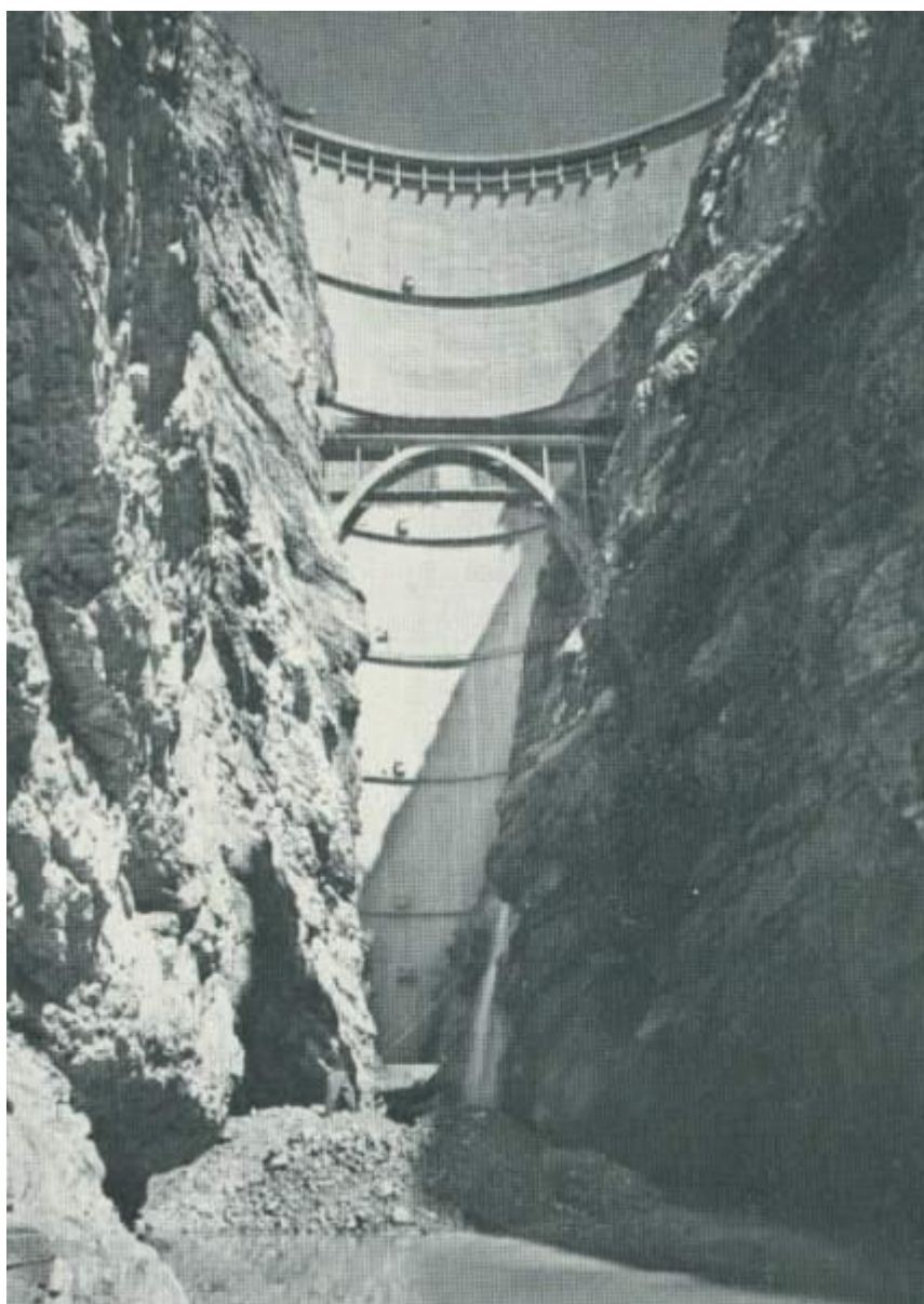
Рис. 2. Плотина Вайонт со стороны нижнего бьефа [8]
