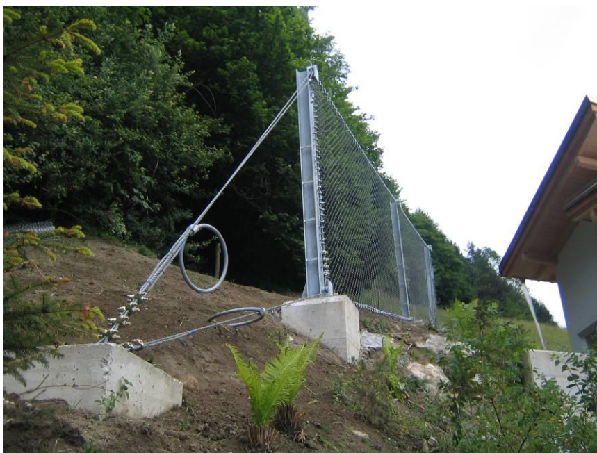
Рисунок 1. Двухсекционный противокампедный барьер для защиты здания, Австрия.
