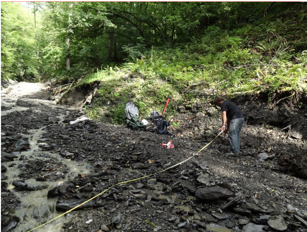
Рис. 4. Разметка точек крепления несущих канатов
