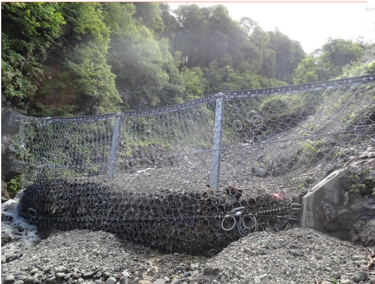
Рис. 5. Первый в современной истории России гибкий противоселевой барьер производства Geobrugg AG, удержавший селевую массу.
