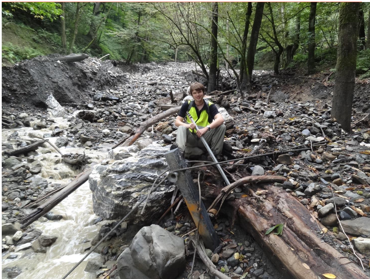
Рис. 6. Остатки конструкции гибкого противоселевого барьера, спроектированного без опыта работ в области инженерной защиты от селей
