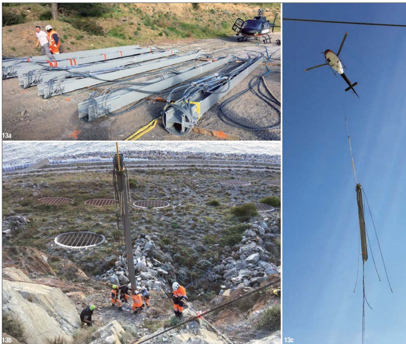
Рис. 7. Монтаж защитных систем при помощи вертолета
