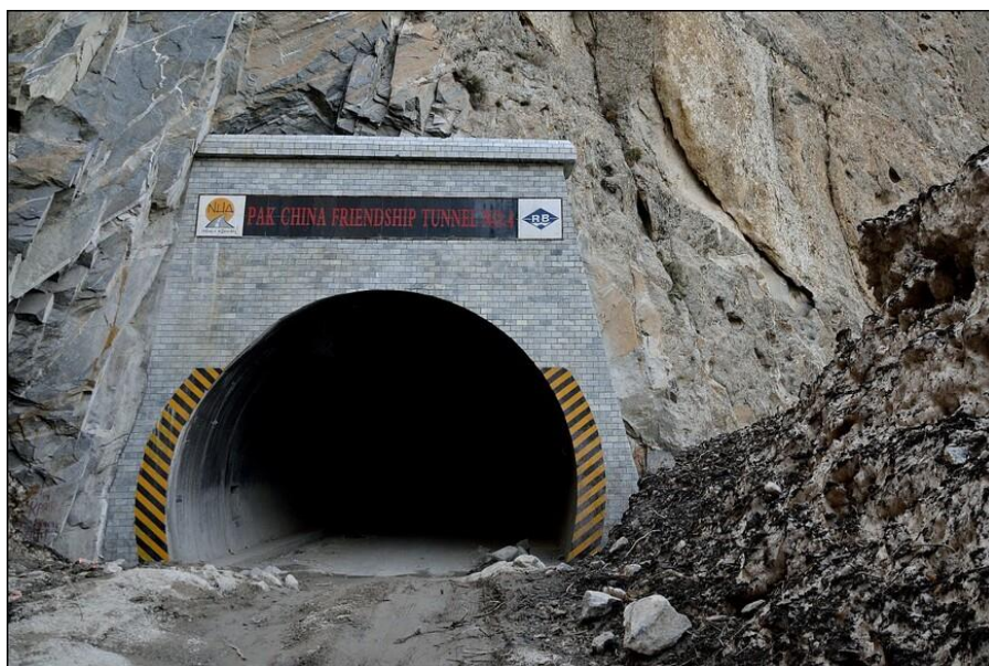
Рис. 6. Тоннель на «Каракорумском шоссе» [4]
