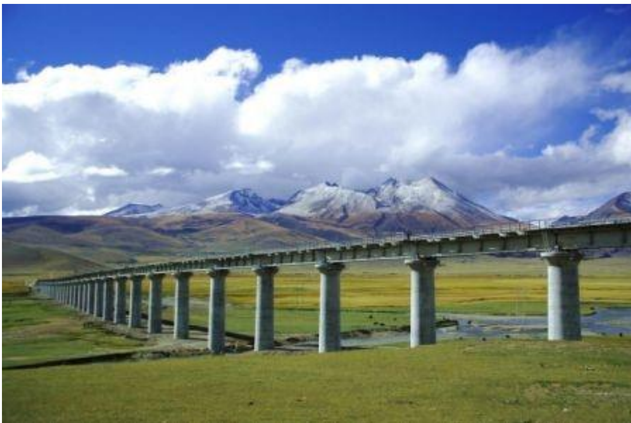
Рис. 16. Мостовой переход с применением термосифонов [9]
