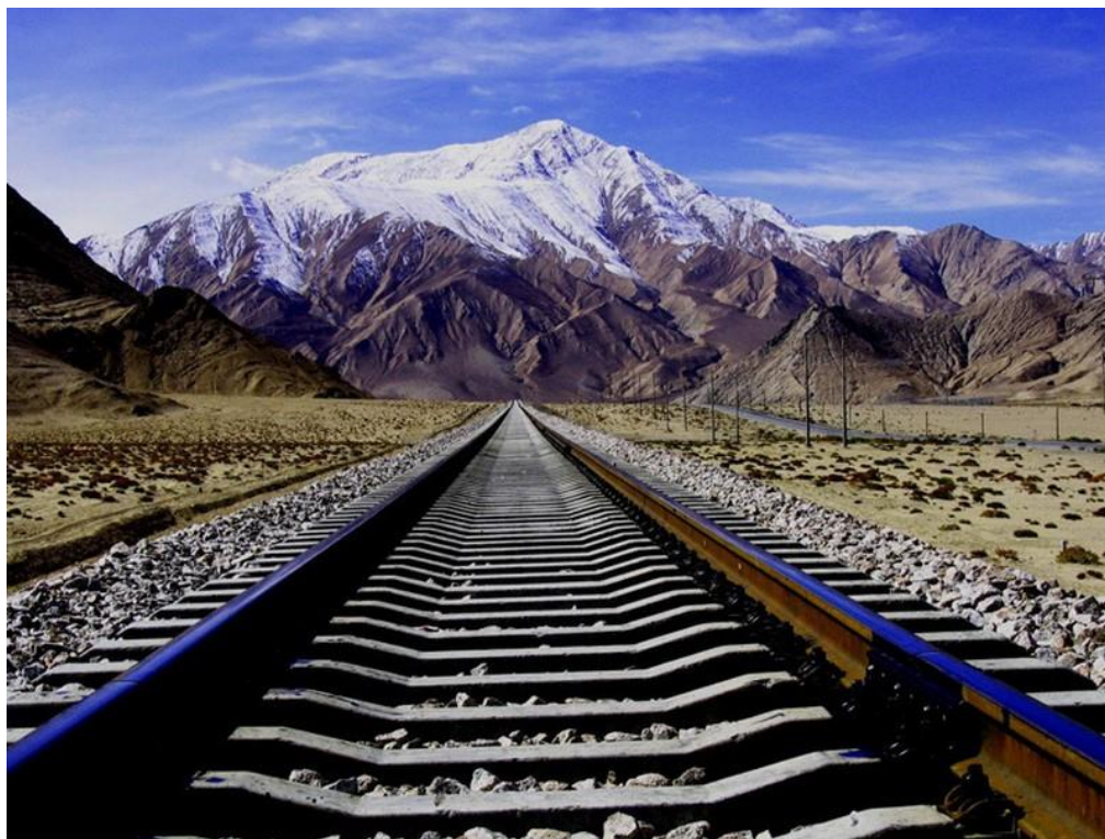
Рис. 22 Состояние путей на участке около высокогорного массива [15]
