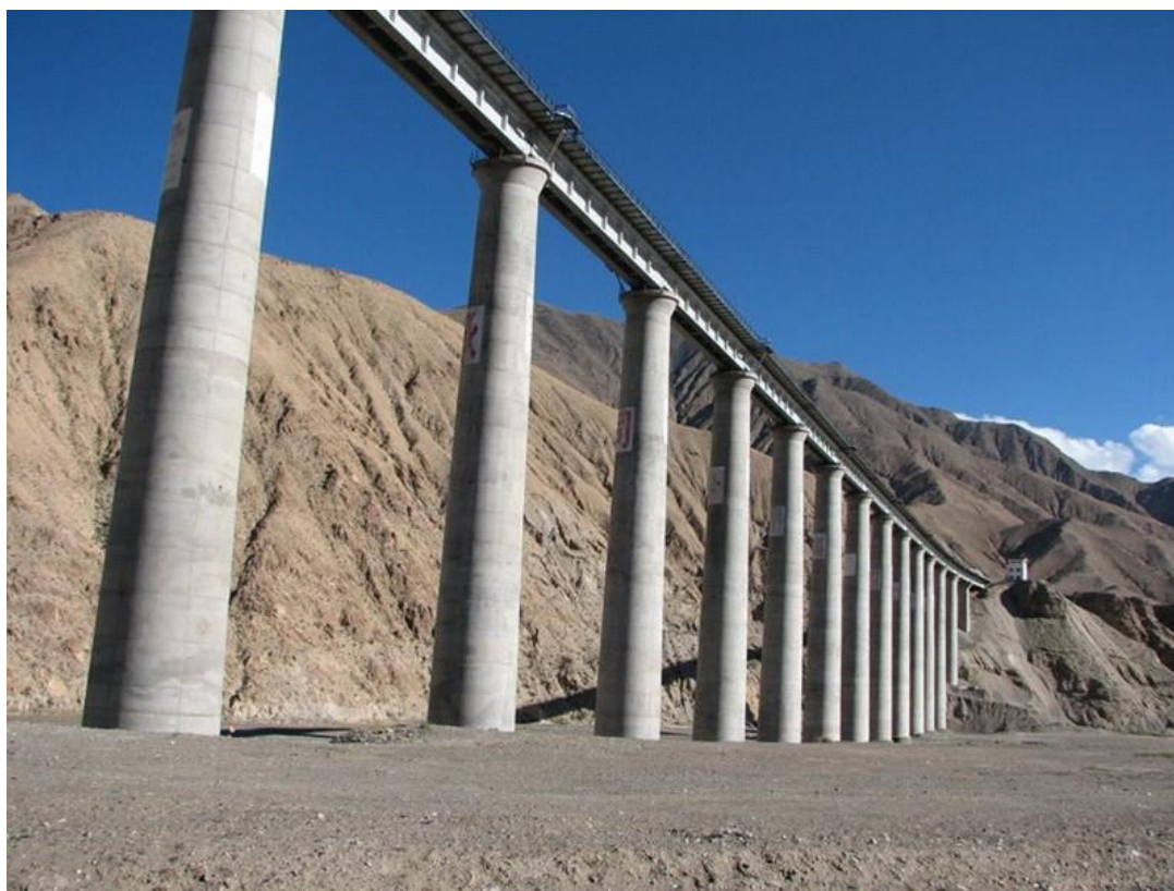
Рис. 18. Пересечение межгорной впадины с применением термосифонов [9]
