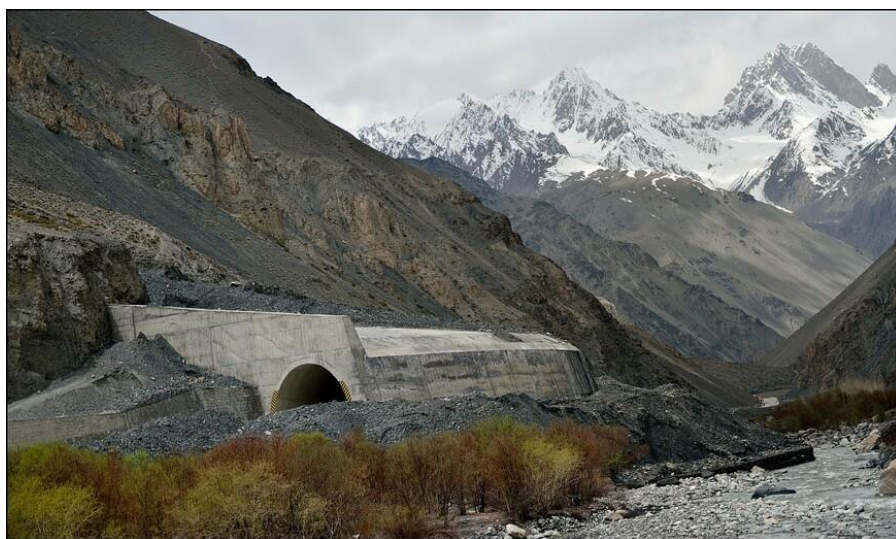
Рис. 7. Тоннель на «Каракорумском шоссе» [4]
