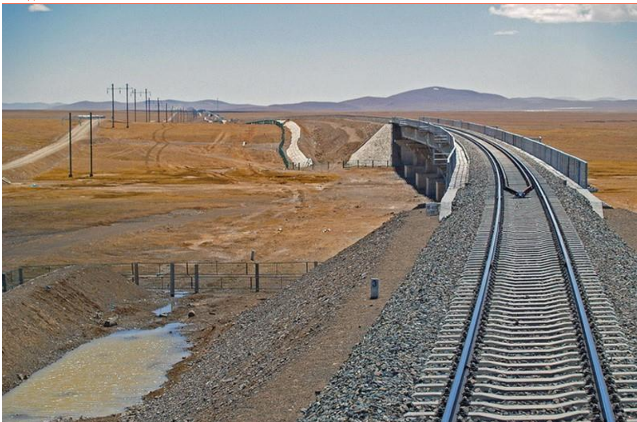
Рис. 15. Мостовой переход с применением термосифонов [8]
