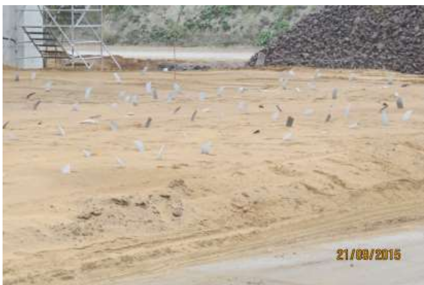
Рис. 5. Поле геодрен для отжатия воды из илов, подстилающих намывную (насыпную) песчаную толщу
