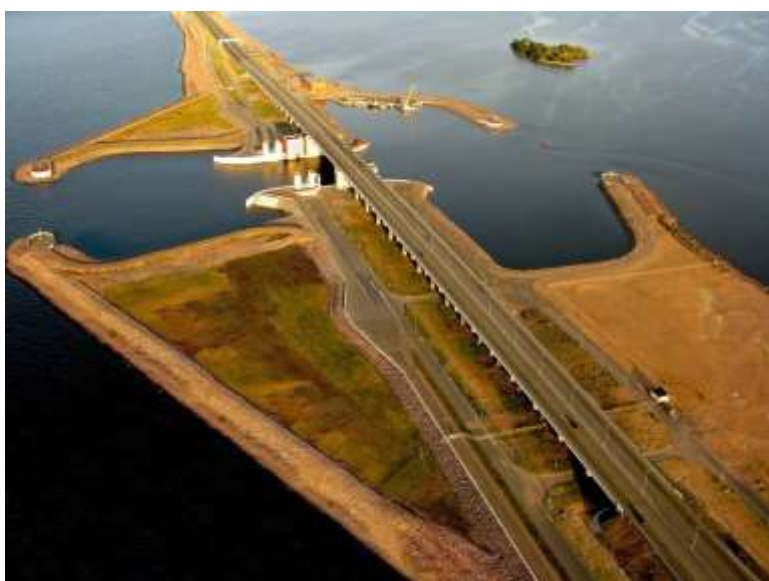
Рис. 2. Участок Комплекса защитных сооружений Санкт-Петербурга от наводнений, введенного в эксплуатацию в 2011 году [5]
