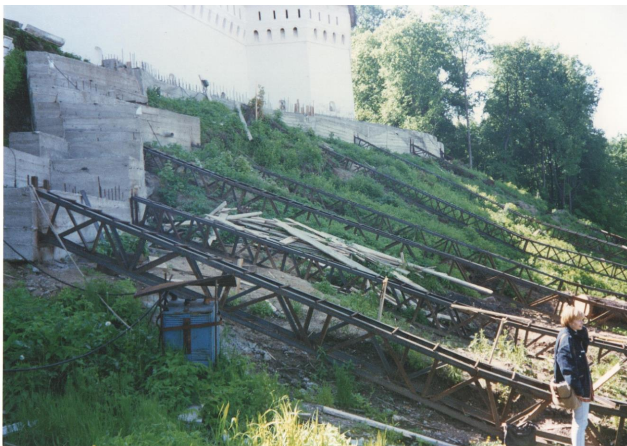
Рис. 3. Попытка укрепления оползневого склона Воскресенского Ново-иерусалимского монастыря
