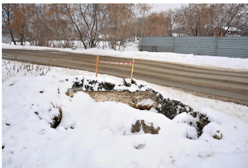
Рис. 4. Провал участка дороги с повреждением обочины в г. Березовском
