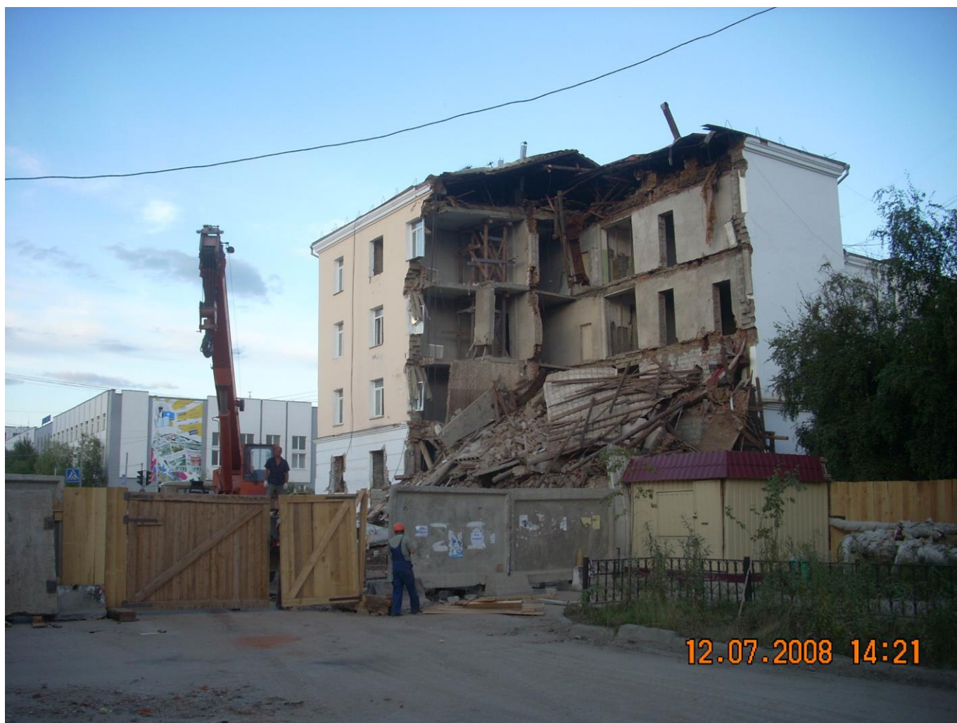
Рис. 3. Разрушение каменного здания в Якутске из-за нарушения несущих конструкций основания. Фото С.И. Серикова
