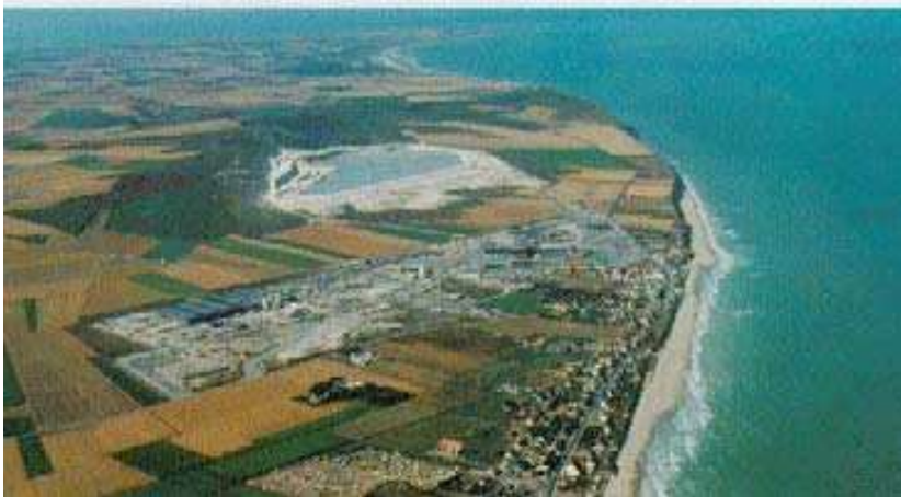
Рис. 9. Французское побережье пролива Па-де-Кале в районе Сангатта во время проходки Евротоннеля. Ближе видна рабочая площадка с заводом по изготовлению сегментов бетонной обделки и шахтой для доступа к строящимся тоннелям, дальше – плотина Фонд Пино, удерживавшая пульпу из воды и вынутого при бурении тоннелей грунта [28]
