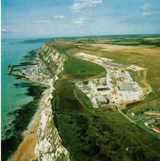
Рис. 7. Утес Шекспира и огороженная дамбой нижняя рабочая площадка под ним, постепенно все более заполняемая вынутым при строительстве тоннелей грунтом. Наверху утеса видна верхняя рабочая площадка с заводом по изготовлению бетонных сегментов обделки тоннелей (фото 1988 г.) [28]
