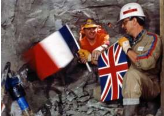
Рис. 12. Встреча строителей, буривших британскую и французскую части служебного тоннеля навстречу друг другу [11]
