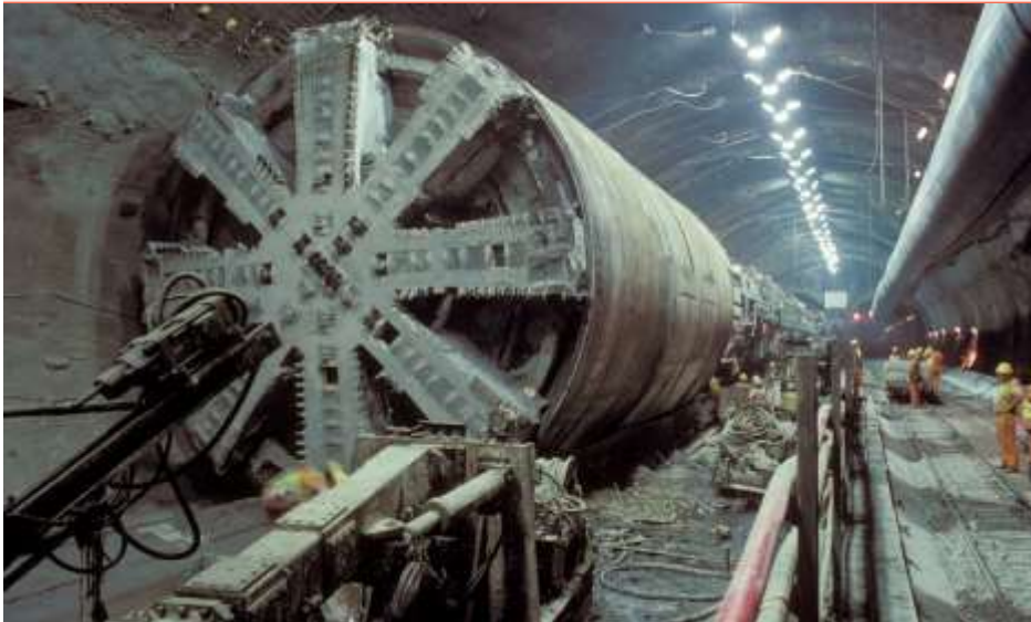
Рис. 10. Тоннелепроходческий комплекс, использованный при строительстве железнодорожного тоннеля под Ла-Маншем [18]
